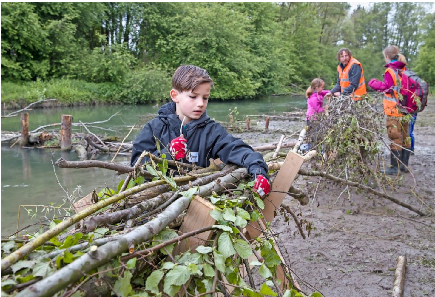
Mit voller Konzentration an der Arbeit: Timon Gueth legt die Drahtschleife um die Äste, die Faschine ist schon fast fertig.
