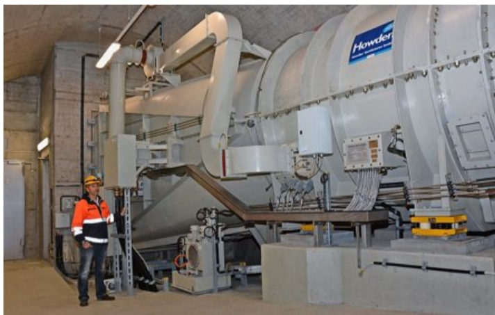
Kleiner Mensch, grosse Maschine: BLS-Mechanikermeister Daniel Suter lässt die Dimension des Lüfters im Mitholzstollen erahnen.
