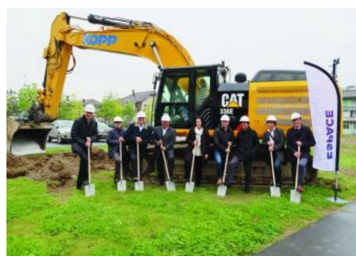
Der Spaten steckt und die Bauarbeiten können starten. Hannah Frei
