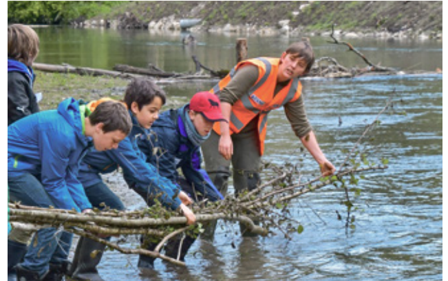
Teamwork: Vorsichtig werden die Bündel aus Ästen, sogenannte Fascinen, in die Alte Aare gelegt. Sie bieten Fischen neuen Lebensraum.
