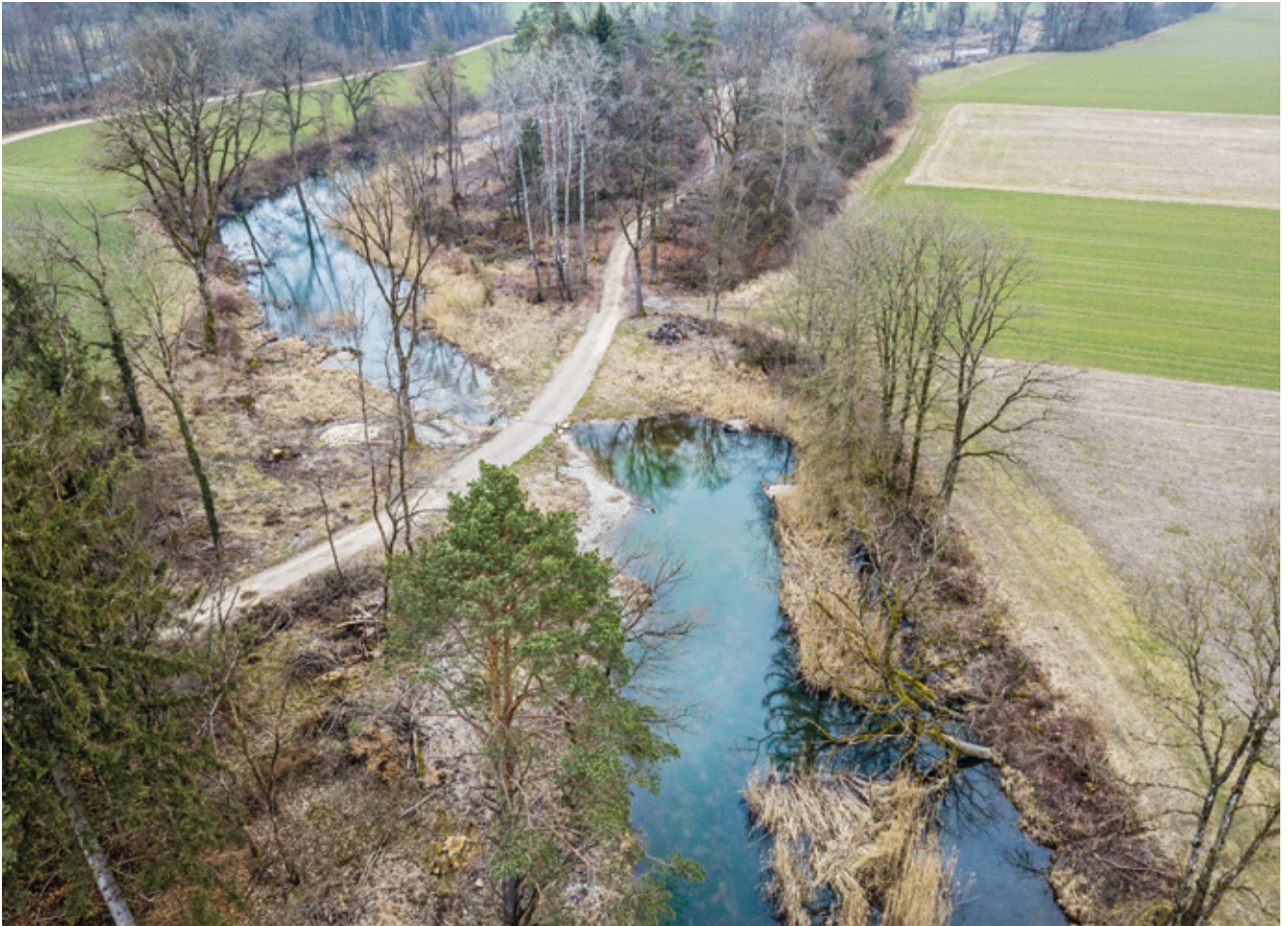
Das alte Seitengerinne der Alten Aare wurde reaktiviert und dient sowohl dem Hochwasserschutz als auch der ökologischen Aufwertung.
