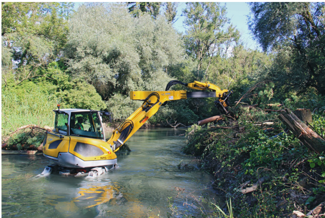
Nur nicht einsinken: Mit schweren Maschinen im Wasser zu arbeiten, braucht viel Feingefühl.
