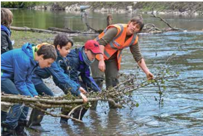
Teamwork: Vorsichtig werden die Bündel aus Ästen, sogenannte Faschinen, in die Alte Aare gelegt. Sie bieten Fischen neuen Lebensraum.
