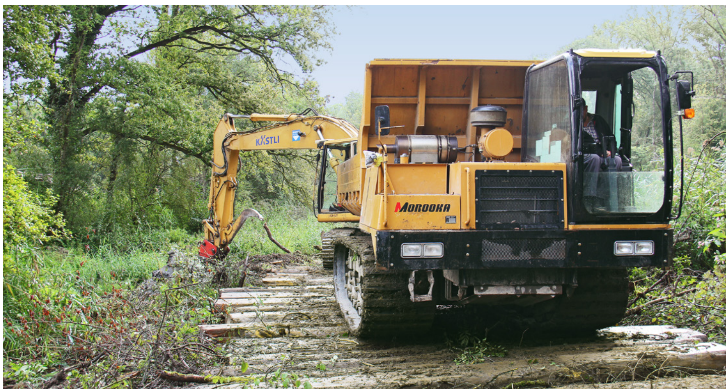
Die Baggermatratze verhindert das Einsinken der schweren Baumaschinen.
