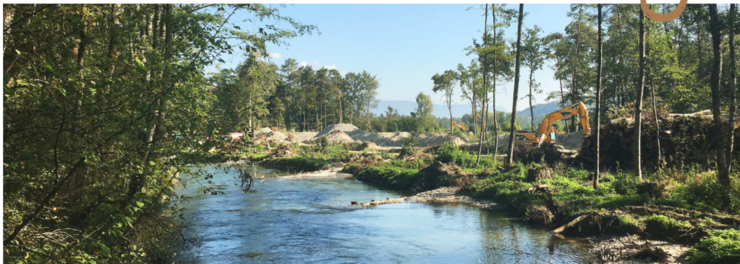
Zwitschernde Vögel und Baulärm: Baustelle Grossried im September 2018.
