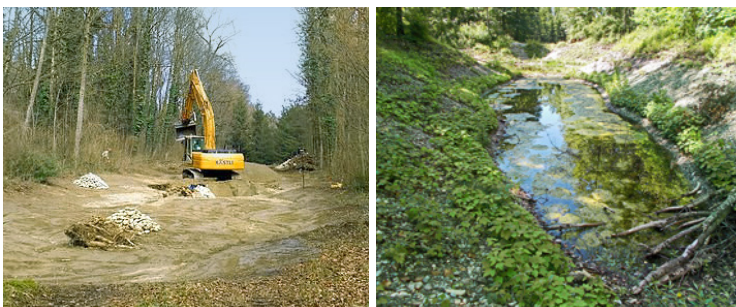
März 2016: Neuer Lebensraum für gefährdete Amphibien im Bau... ...und heute.
