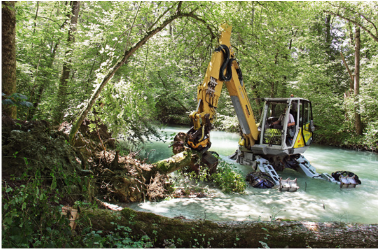
Die Bagger leisten Starthilfe für einen natürlichen Flusslauf an der Alten Aare. Die Schlussgestaltung obliegt jedoch der Natur.
