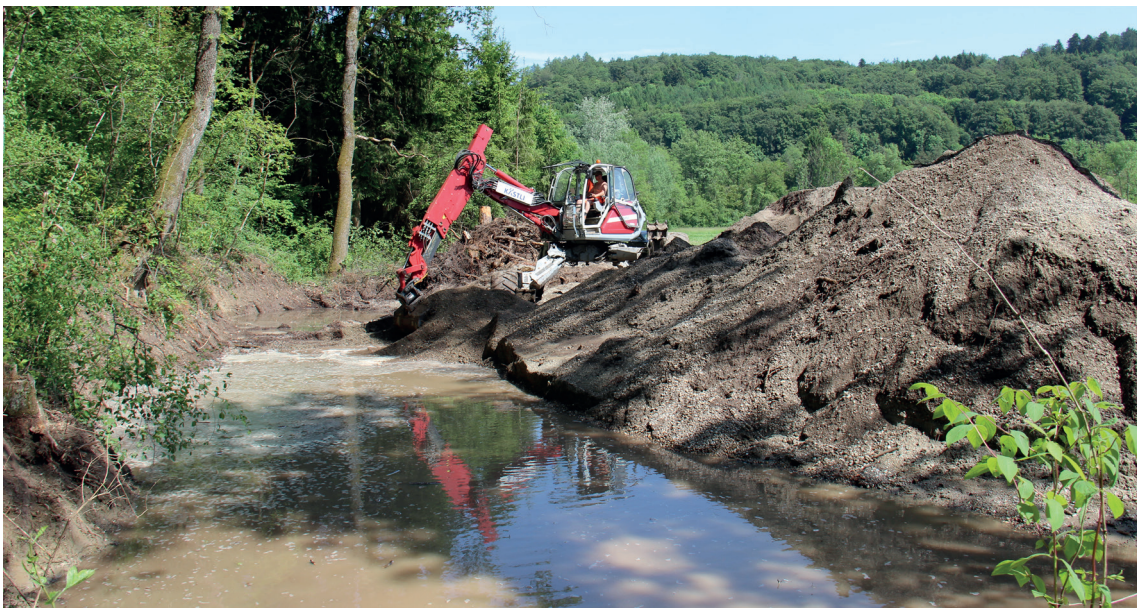
Ein neues Amphibiengewässer entsteht – hier im Schwadernau.
