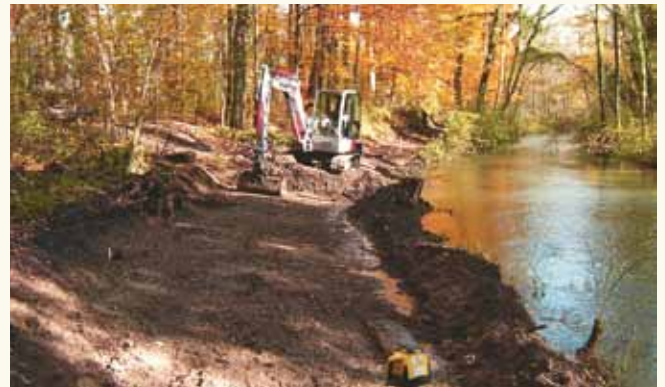
Uferabflachungen bei Aarberg (Aufwertungsmassnahmen im Rahmen eines Projektes der Zuckerfabrik Aarberg)
