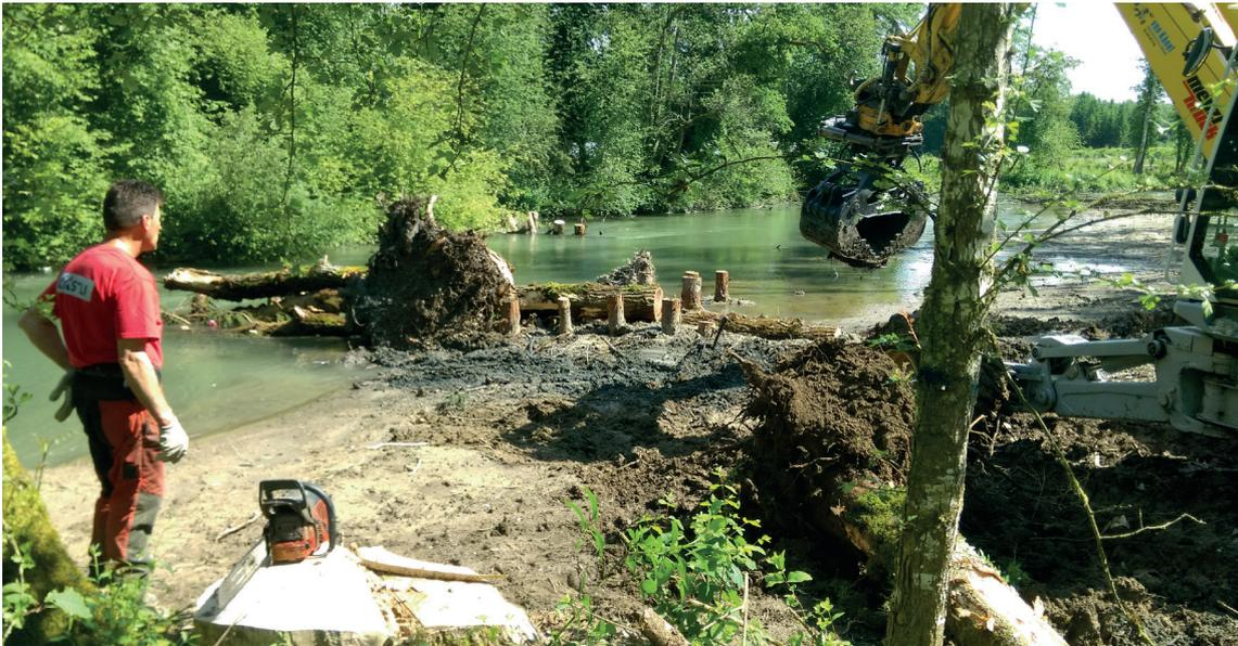
Einbau einer Stammverkeilung. Die Strömung wird durch diese Totholzstruktur verändert. Es entstehen neue Lebensräume und gute Verstecke für Fische.
