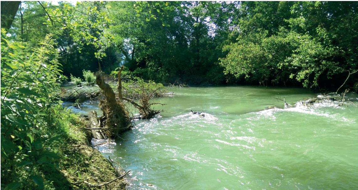
Eingebaute Stämme, Wurzelstöcke und Äste bewirken, dass die Strömung des Wassers und somit auch die Struktur des Flussbetts abwechslungsreicher werden.
