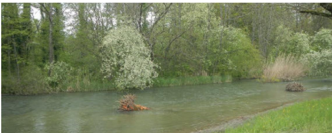
Im Zuge des Projekts Hochwasserschutz und Revitalisierung wurden Hartholzauen, die sich bis zum Ufer ausgedehnt hatten, gerodet und das Terrain wurde abgetragen, sodass sich die Weichhölzer unter neuen Bedingungen wieder etablieren können. Ufer wurden zum Teil abgeflacht, um das Wasser über die Ufer treten zu lassen und Strukturen in das Gerinne eingebaut, um die Strömung zu verändern.
